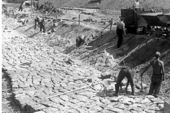
Abb. 2.5: Pflasterarbeiten an der Alten Rench, 1954
