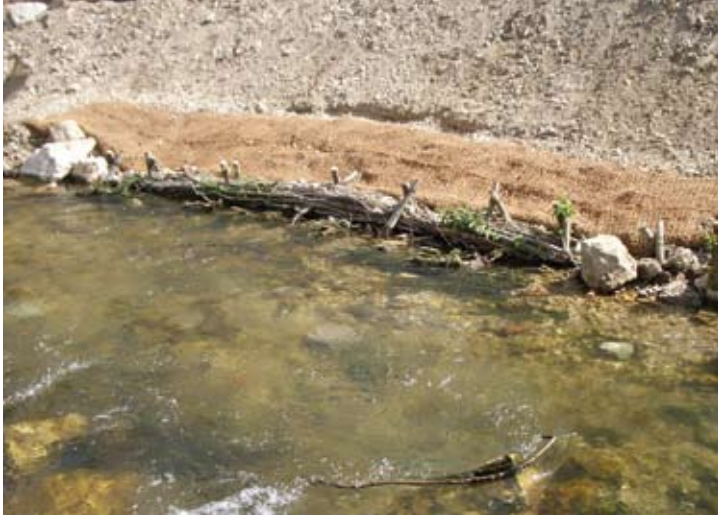
Abb. 2.16: Uferfaschine mit Naturfasertextil (Lauter in Kirchheim/Teck)
