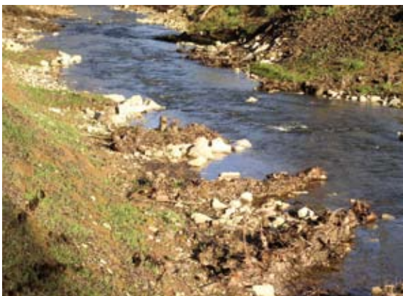
Abb. 2.30: Kleine Faschinen-/Steinbuhnen (Körsch in Deizisau)
