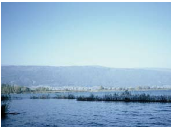
Abb. 4.42: Uferschutzmaßnahmen mittels Lahnungen (Bieler See)
