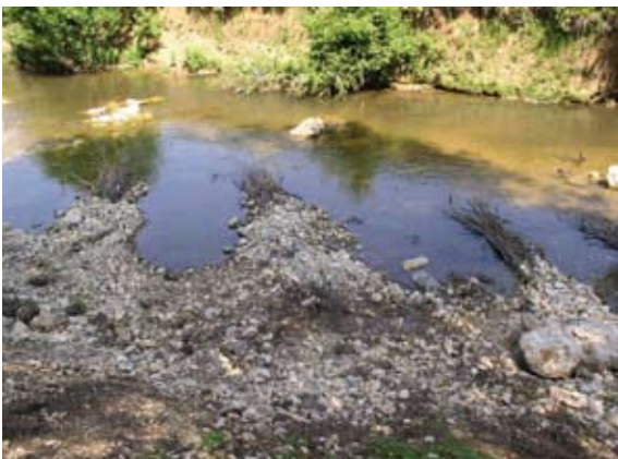
Abb. 2.34: Faschinenbuhnen (Kocher in Hüttlingen)
