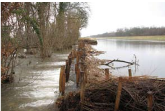
Abb. 2.41: Geschwemmselg bei Hochwasser (Leopoldskanal bei Rheinhausen)
