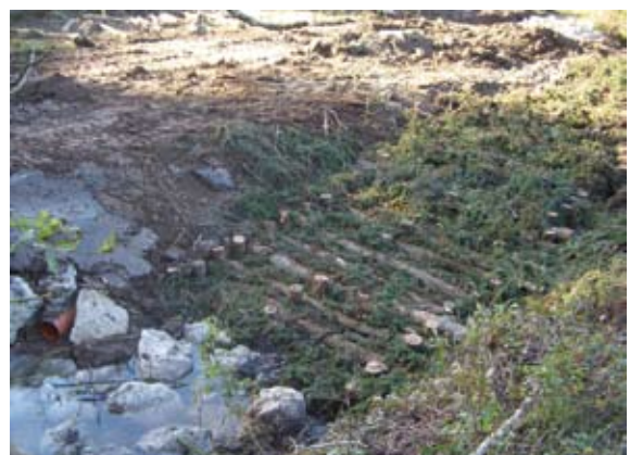
Abb. 2.21: Knüppelrampe (Bottwar in Großbottwar)
