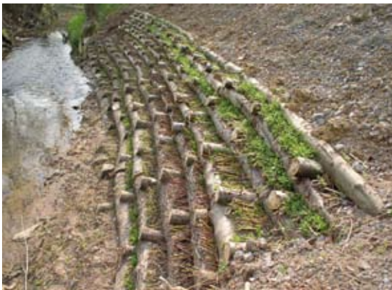
Abb. 4.32: Krainerwand (Bottwar bei Oberstenfeld)
