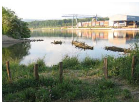
Abb. 4.43: Lahnung als Schutz vor Wellenschlag (Hochrhein/Grenzach-Wühlen)
