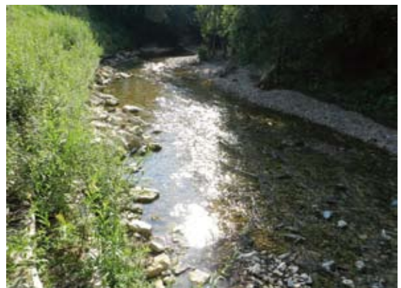
Abb. 2.31: Tauchbuhnen zur Strömungsablenkung am Außenufer (Lindach bei Kirchheim)
