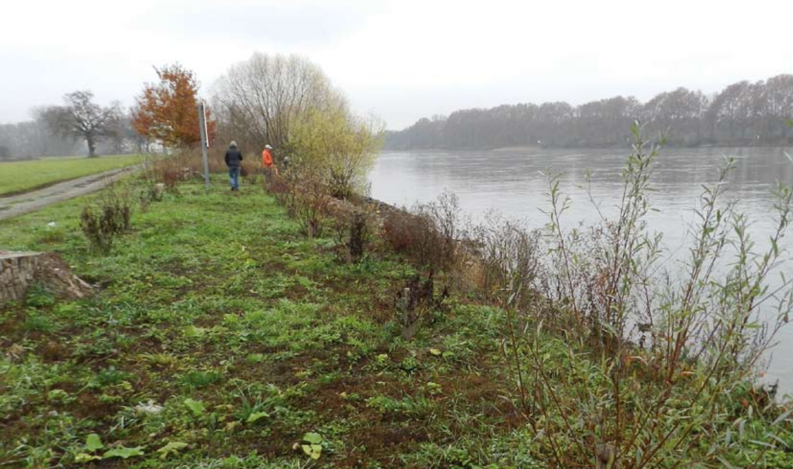
Abb. 2.36: Weidensetzstangen als schlafende Sicherung (Rhein bei Worms)
