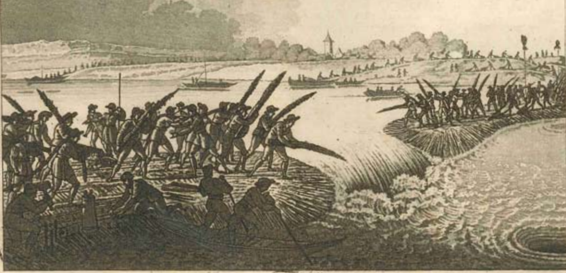
Faschinenbau bei einer Stromverwirrung
