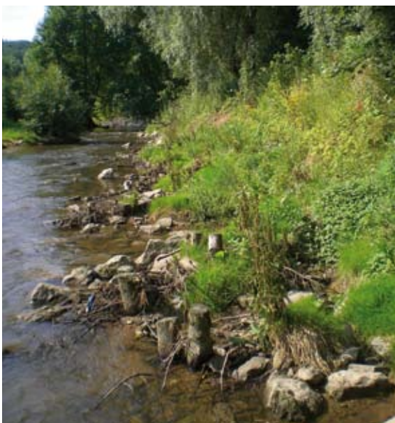
Abb. 4.21: Entwickelte kleine Bühnen und Stummelfaschinen (Körsch bei Deizisau)
