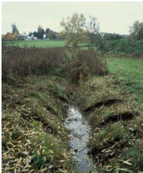
Abb. 3.8: Entnahme von Hochstaudensoden (Bonlandenbach in Reutlingen)
