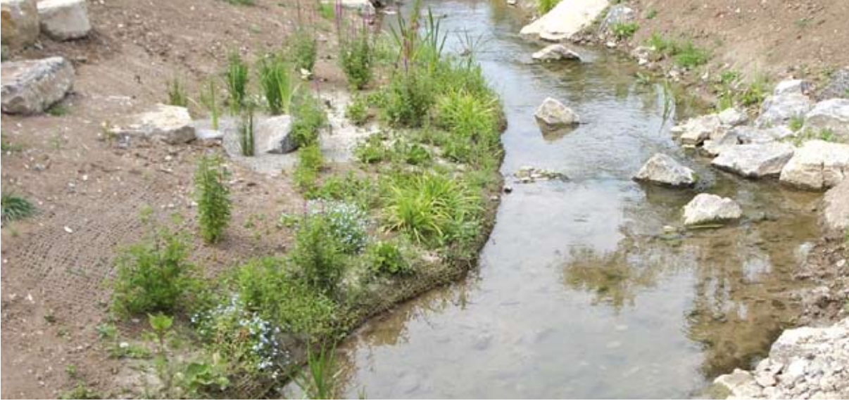
Abb. 4.36: Vegetationswalze (Rankbach bei Renningen)
