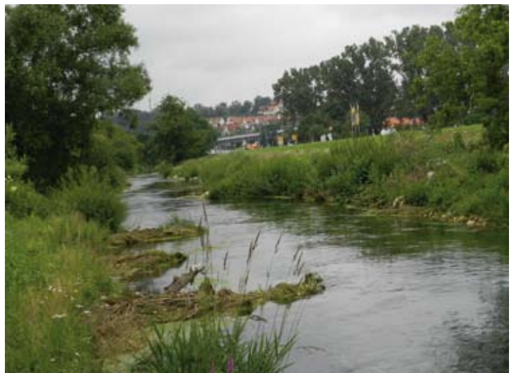
Abb. 2.23: Entwickelter Raubaum nach zwei Jahren (Brenz in Giengen)
