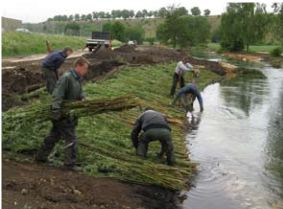
Abb. 4.7: Auslegen der Weidenruten auf einer Böschung (Brenz bei Giengen)
