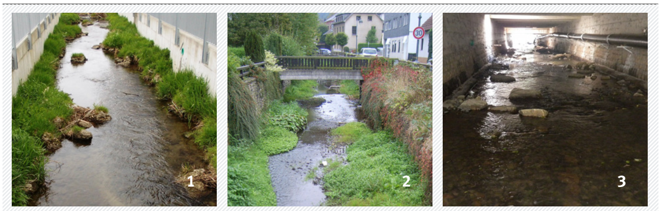
1 Bach zwischen Betonwänden 2 Eipbach in Ortslage 3 überbauter Bach mit Lichtschächten und offener Sohle
