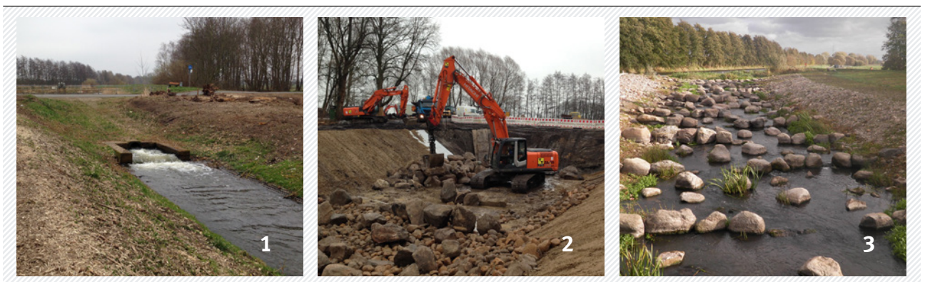
1 Streichwehr vor Maßnahmenbeginn 2 Rückbau 2015 3 durchgängiger Beckenpass 2018
