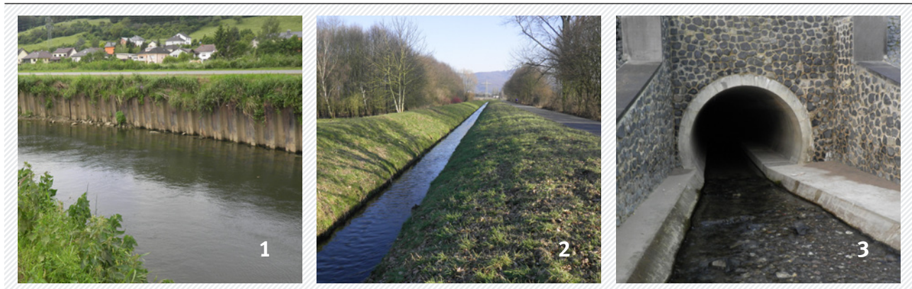
1 mit Spundwänden gesichertes Flussufer 2 begradigter Bach 3 verrohrter Abschnitt des Mehlemer Baches
