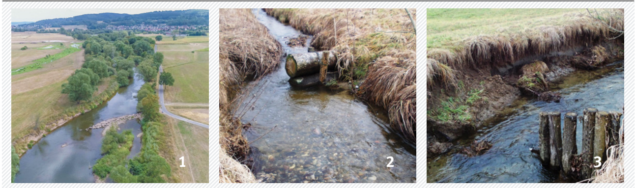
1 Steinbuhne 2 Stambuhne 3 Pfahlbuhne
