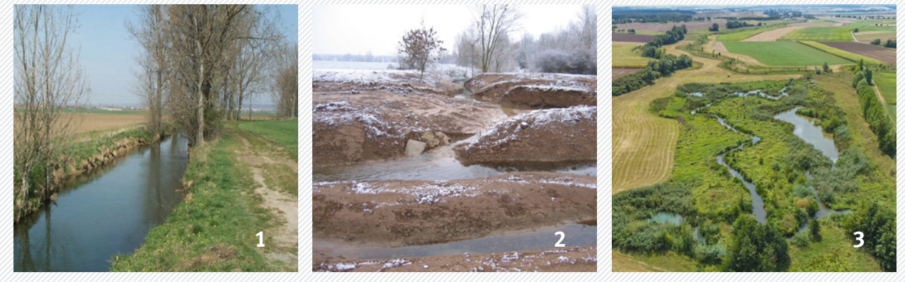
1 begradigter Abschnitt der Wern 2 Wern bei Geldersheim während der Bauphase 2005 3 Wern bei Geldersheim 2018
